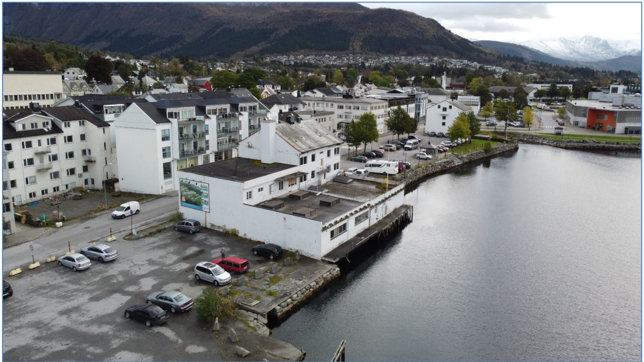
Figur 2.14.3 Fasade mot sjø og vest
